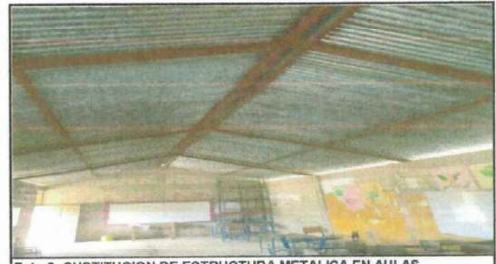
Foto 6: SUSTITUCION DE ESTRUCTURA METALICA EN AULAS
