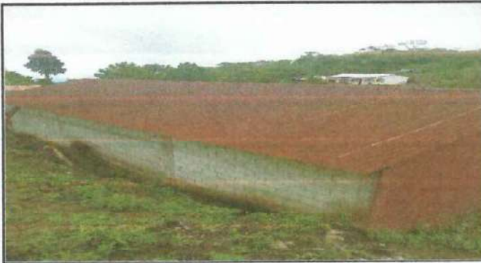
Foto 1: SUSTITUCION DE CUBIERTA DE LAMINA EN MAL ESTADO EN AULAS
