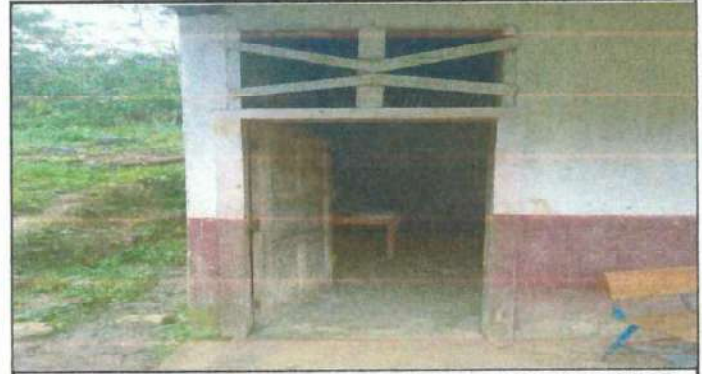
Foto 4: SUSTITUCION DE PUERTAS DE MADERA EN MAL ESTADO POR PUERTA DE METAL
